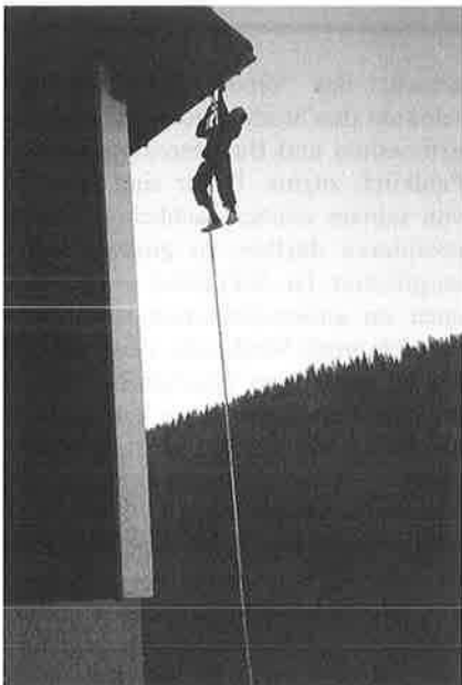
Waghalsige Reparaturarbeiten durch Prof. Hubert Egger.
