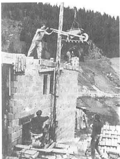
Erstellung des Rohbaues 1960
