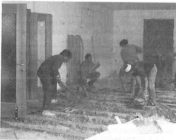
Ausräumen des Speisesaales
