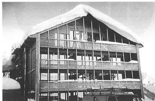
Neubau Hotel Widderstein in Schröcken, Bauleitung
