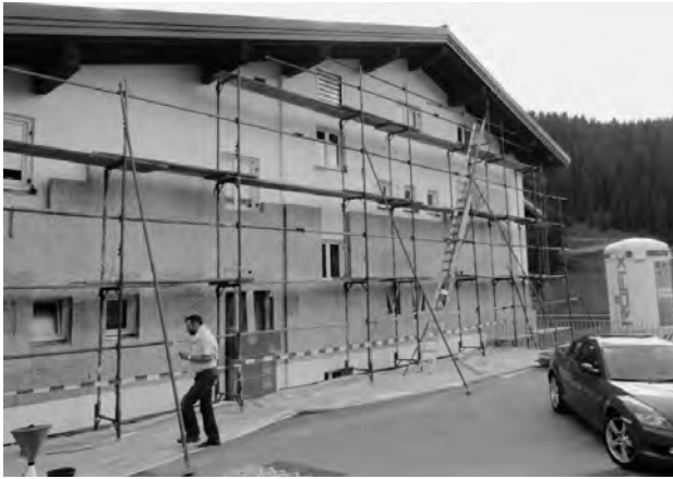
Thermische Außensanierung JHL, Stand 26.5.2011
